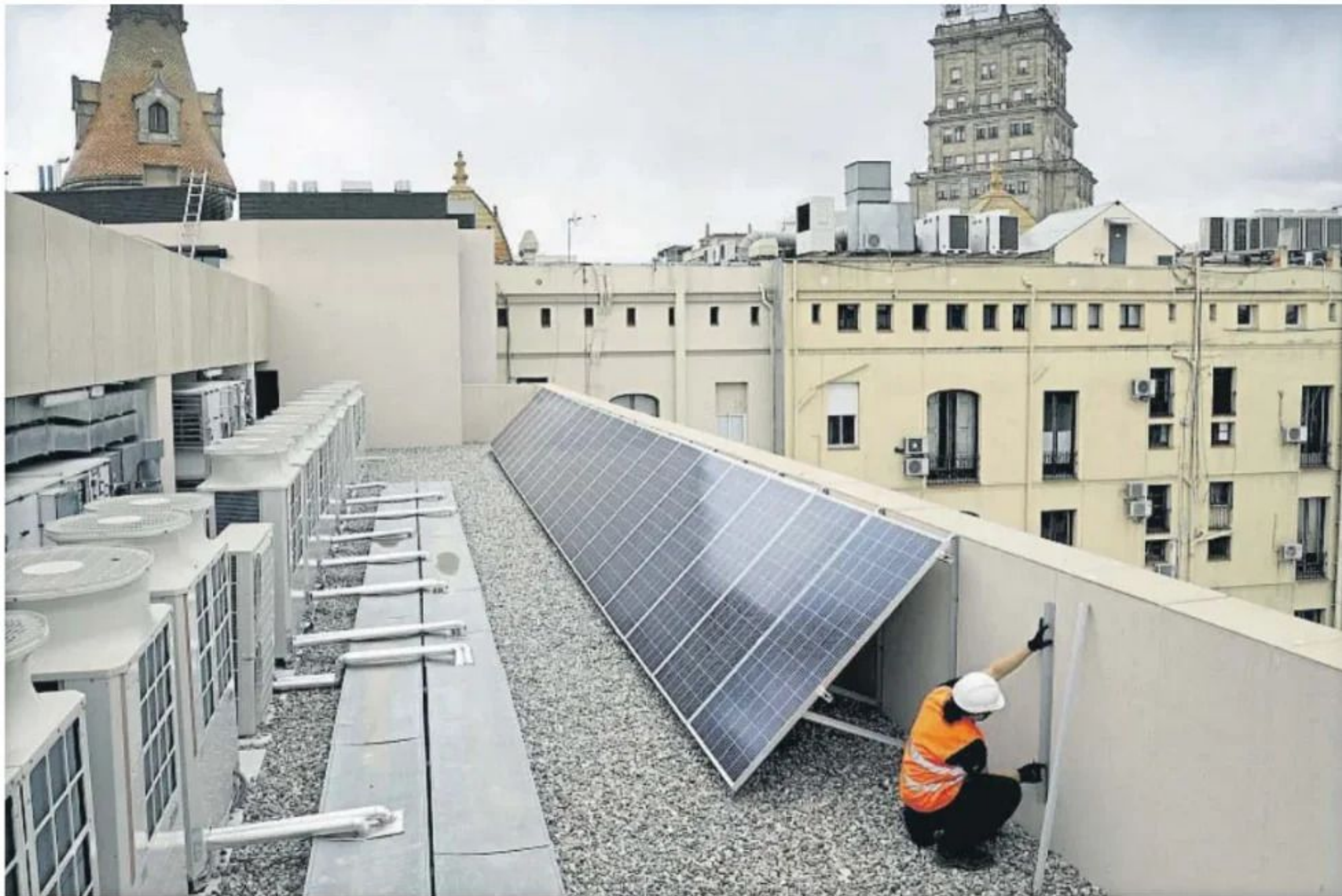
Instalador de placas solares en un edificio del Eixample de Barcelona
